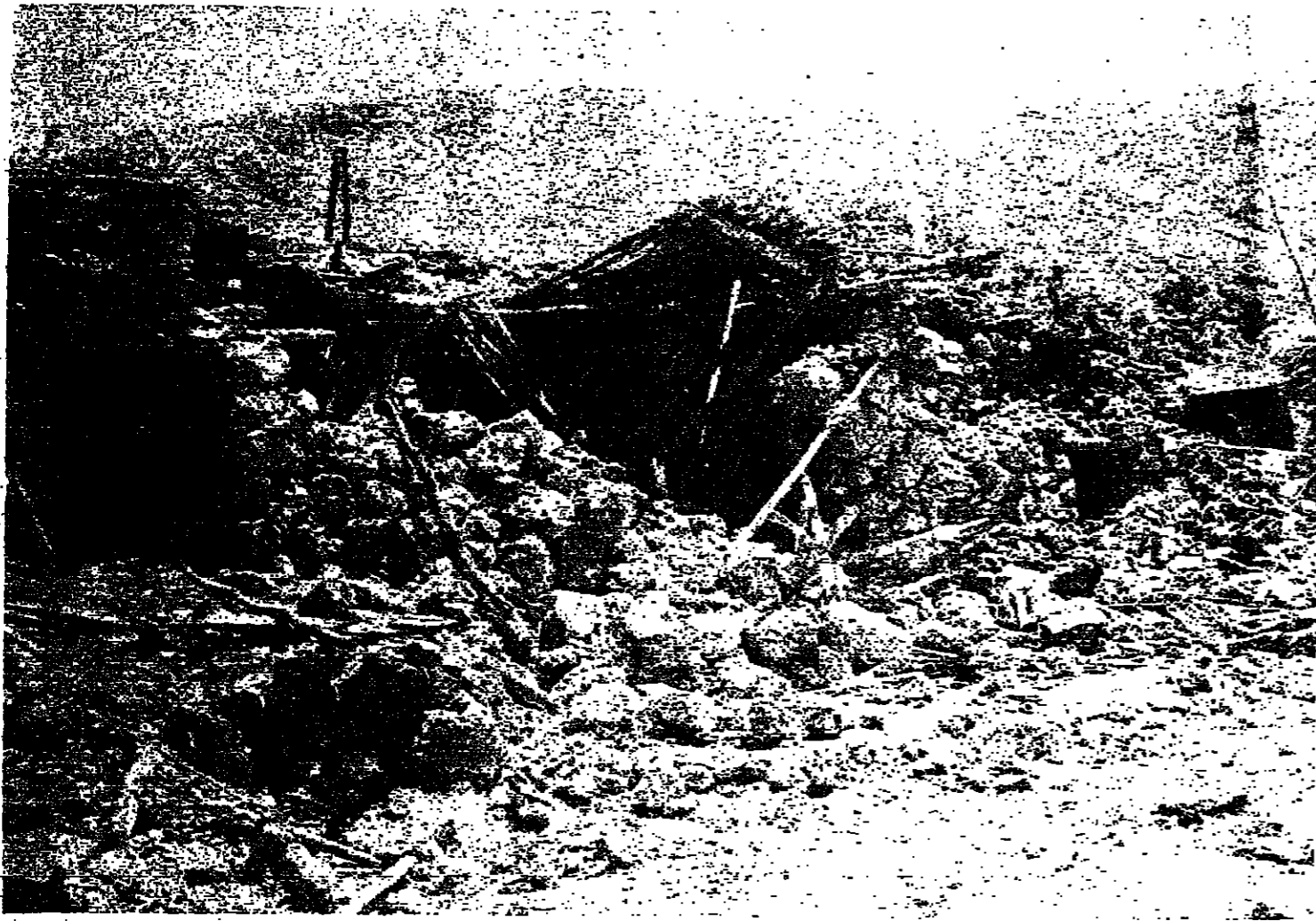
جانب من الخراب الذي خلفه القصف الإسرائيلي في بلدة حام
